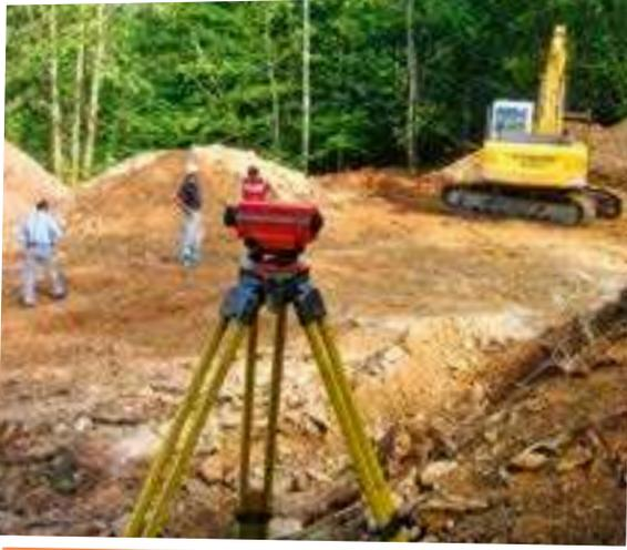
Du führst vor Ort Geländevermessungen durch, z. B. für Bauvorhaben oder um den Verlauf von Grundstücksgrenzen zu klären. Für großräumige Vermessungen setzt Du ggf. auch Drohnen
